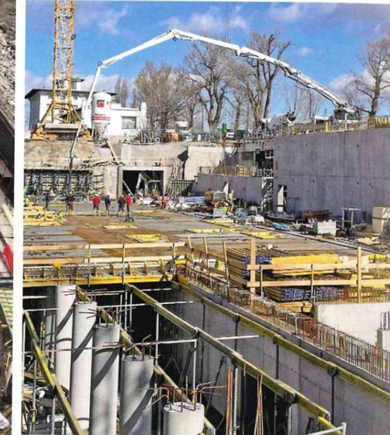
Im hier teilweise noch sichtbaren Untergeschoss befindet sich der Tiefenspeicher für das River Lab. In der Ebene darüber ist im Hintergrund die Hauptöffnung für den Main Channel sichtbar, die einen Durchfluss von bis zu 10 m³ Donauwasser pro Sekunde ermöglicht
