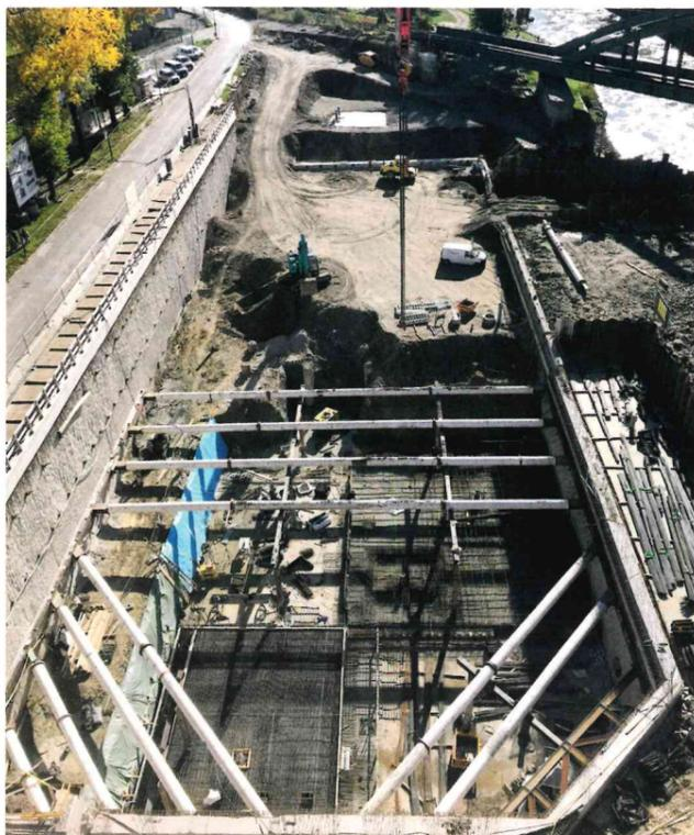
**Stahlaussteifung:** Für die Baugrubensicherung wurden ergänzend zur Schlitzwand durch die Porr Equipment Service 140 t Stahlrohre mit 60 cm Durchmesser quer durch die Baugrube gespannt.
