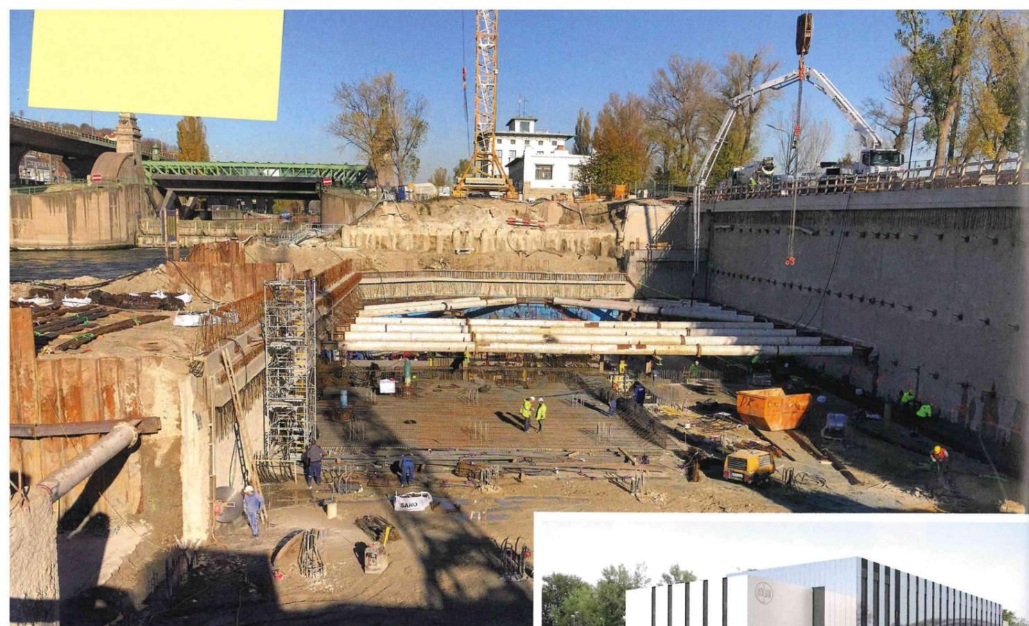
Die Spezialtiefbaumaßnahmen für das neue Wasserbaulabor in Wien-Brigittenau umfassen Schlitzwand, DSV-Körper, Spundwand, aufgelöste Bohrpfehlwand, Nagelwand sowie Pfahlgründung und mussten vielfach zeitgleich ausgeführt werden.
